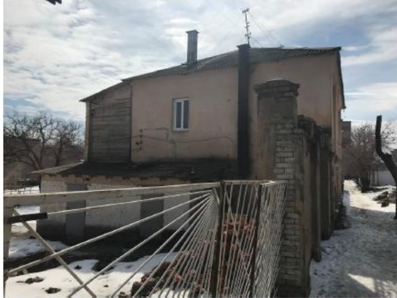
Рис. 13 «Жилой дом (Детский сад №44)», кон XIX-нач. XX вв., ул. Новороссийская, д.28. Северо-восточный фасад
