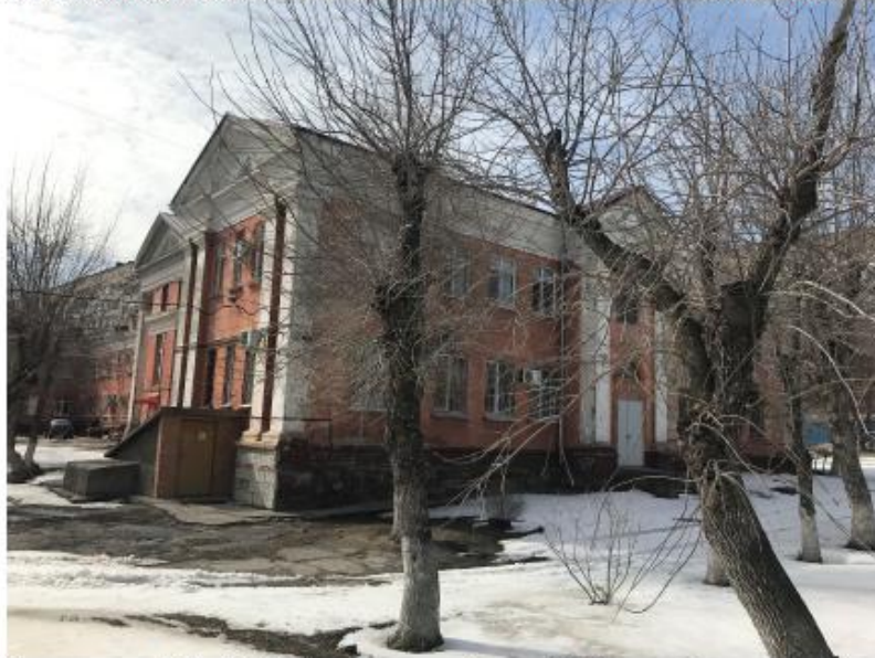
Рис.4 «Поликлиника №12», 1949 г., ул. Новороссийская, д.26. Вид на объект с дворового участка, с юго-востока
